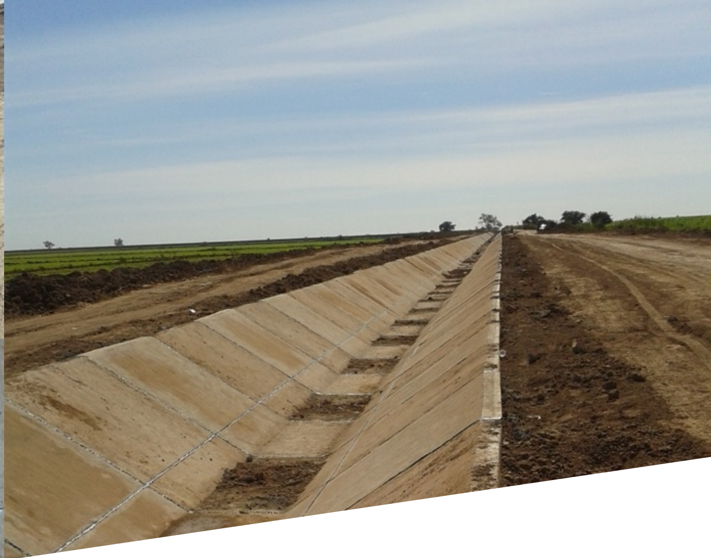
Canal de Riego en Guasabe Plasticem Standar Cemento Plástico Asfáltico/ Membrana de curado (2014)
