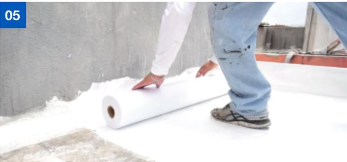
Si se requiere, coloque inmediatamente después de **aplicar la primera capa de Acrilpro 6 años la membrana de poliéster Poliflex**, instalándola alternadamente con la primera capa de impermeabilizante, evitando dejar bolsas de aire y arrugas, esto dará mayor resistencia y duración al impermeabilizante. Deje secar antes de aplicar la siguiente capa.
